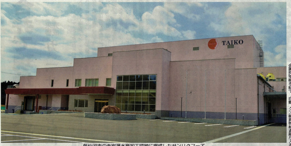
気仙沼市の赤岩港水産加工工場に完成したサンリクフーズ
